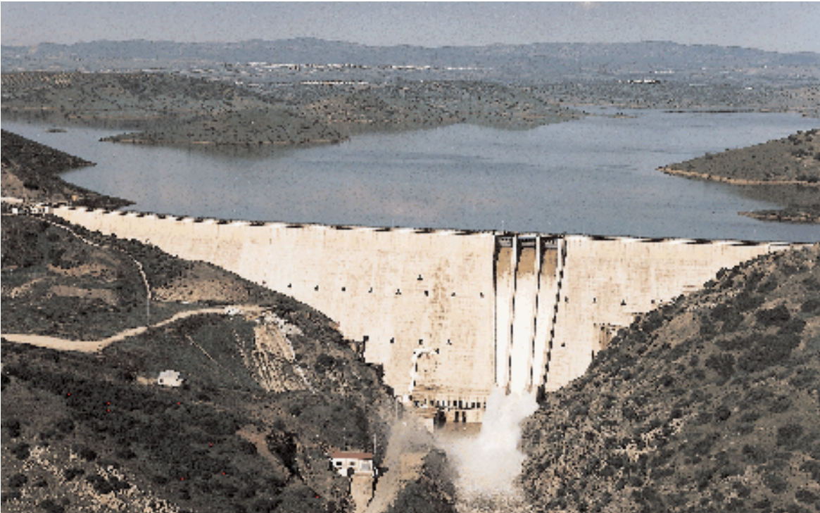
Embalse de La Fernandina en el río Guarrizas, provincia de Jaén
