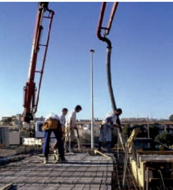
Hormigonado de una estructura.
