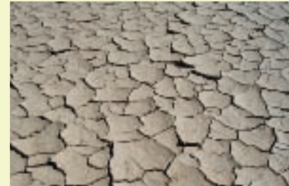
Grietas de desecación (Namibia). Fotografía: E. Pedrinaci.
