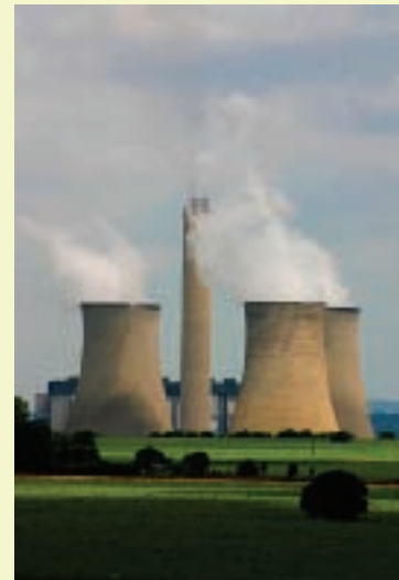
Chimeneas de ventilación de una central eléctrica. Fuente: Comisión Europea, DGMA.
