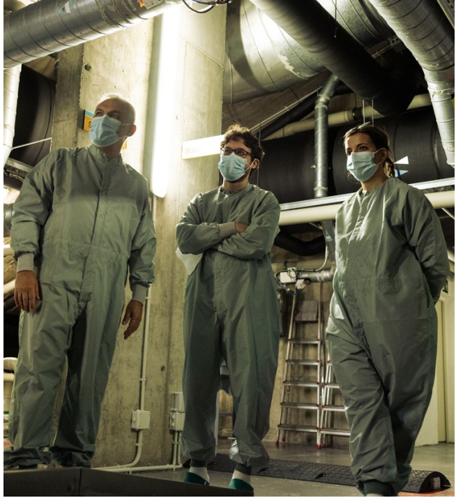
El responsable de biocontención Xavier Abad y la investigadora de coronavirus Júlia Vergara muestran al periodista de SINC Jesús Méndez (centro) la planta de filtrado y ventilación. El sistema se encarga de generar las presiones adecuadas y de descontaminar el aire que se libera al exterior. IMAGEN Guillermo Castellví/SINC
