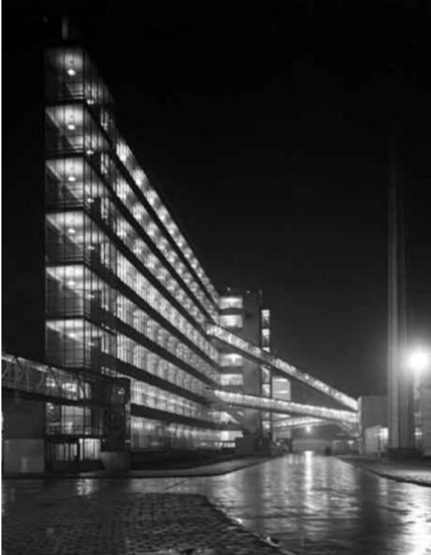
Brinkman & Van der Vlugt: Fábrica Van Nelle, Róterdam, 1927, fotografía de Evert Marinus van Ojen, 1930.
